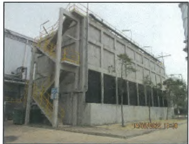
รูปที่ 14 ระบบหอหล่อเย็นของโครงการ
