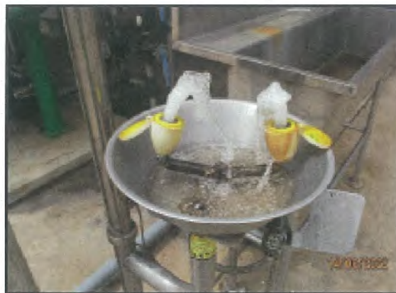
รูปที่ 36 อ่างล้างตา และฝักบัวฉุกเฉิน
