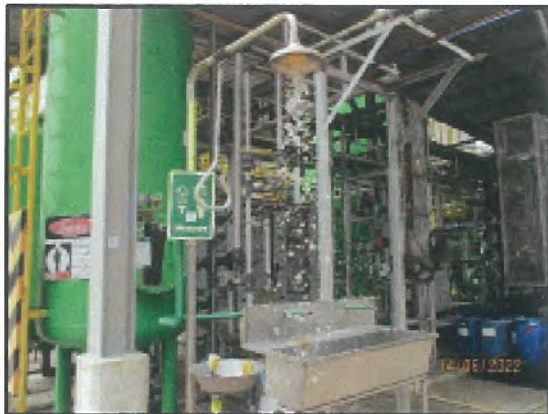
รูปที่ 36 อ่างล้างตา และฝักบัวฉุกเฉิน
