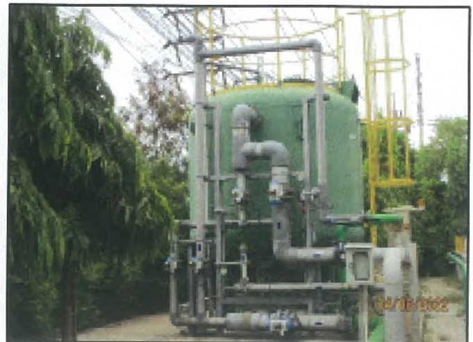
รูปที่ 18 บ่อน้ำฝน (Storm Water Pond) และระบบปรับปรุงคุณภาพน้ำเพิ่มเติม (ระบบกรองทราย)
