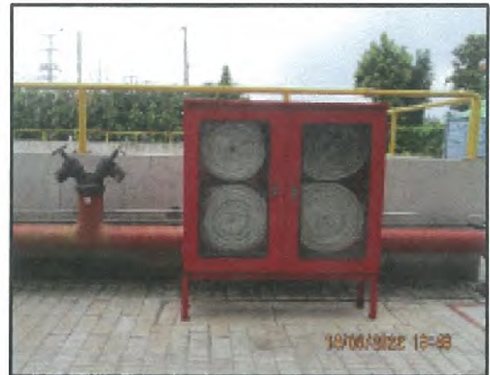
รูปที่ 31 อุปกรณ์ดับเพลิงภายในพื้นที่โครงการ
