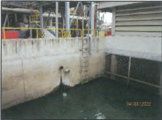
รูปที่ 12 บ่อพักน้ำทิ้ง(Holding pond) ขนาด 600 ลูกบาศก์เมตร
