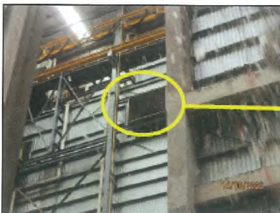
รูปที่ 7 พัดลมดูดอากาศภายในอาคารเก็บเชื้อเพลิง
